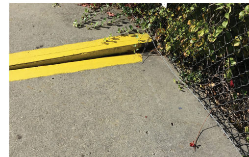
Fig 032. Uneven Pavement Exceeding 1/2"
