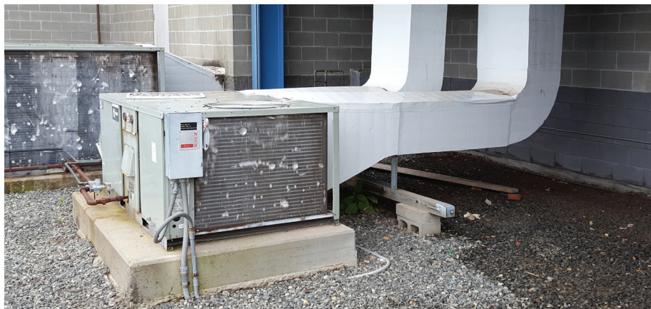
Fig. 052. Exterior Package Unit
